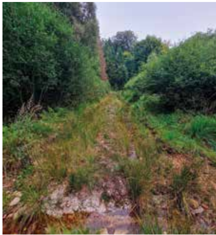
Abb. 1: Zurückgebauter Wegeabschnitt (Abbildung: Boettge)
