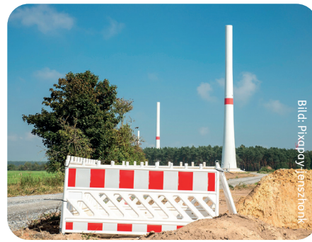
Für den Bau eines Windrades benötigt man etwa ein halbes Jahr.
